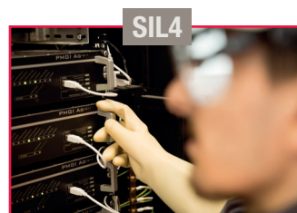
Poste de Manoeuvre Géographique Informatisé
